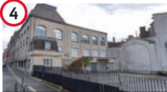
4 RUE GAL SARAIL - MAIRIE DE ROUBAIX 4 750 M 2 - ROUBAIX
