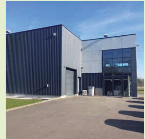
PONT À MARCQ
